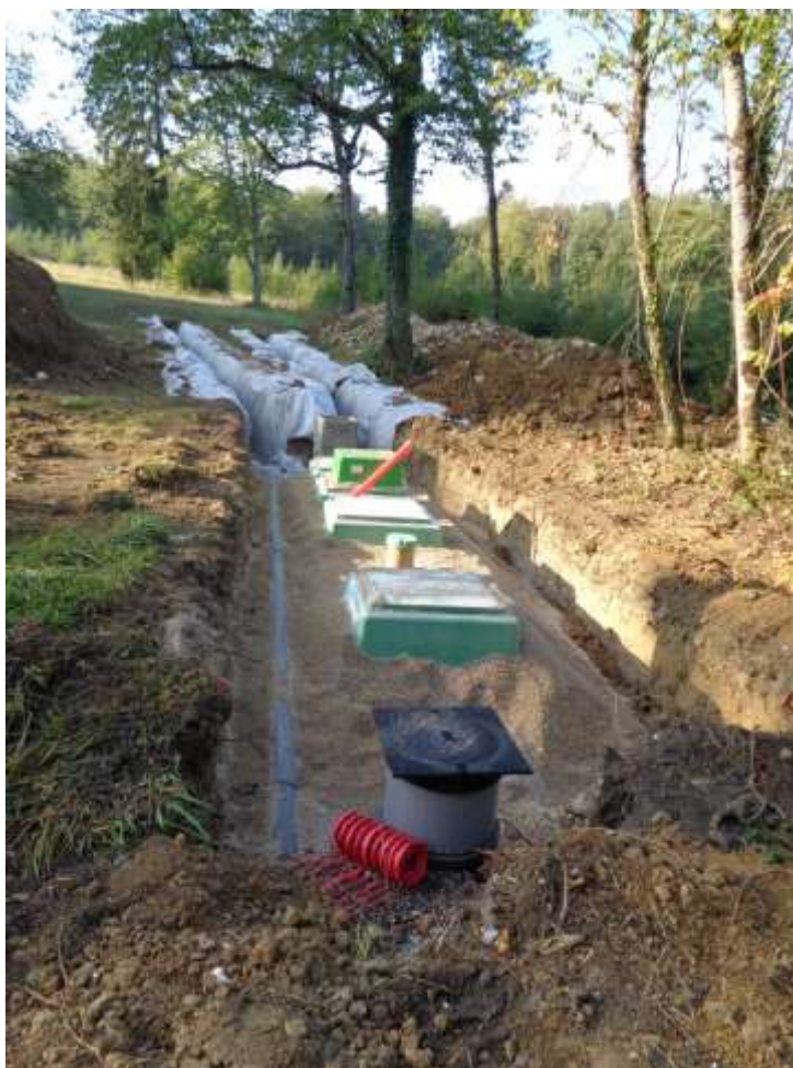
Contrôle d'une installation ANC en construction
