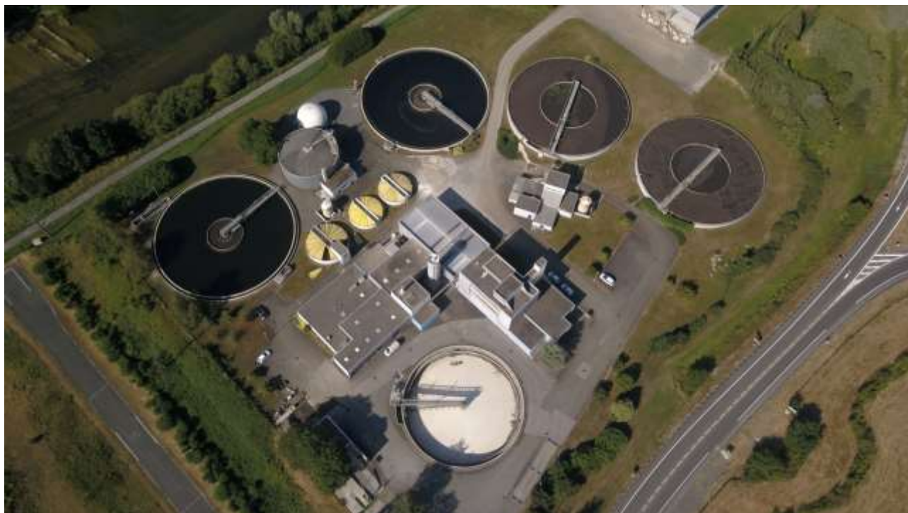
Station d'épuration d'Arbouans
